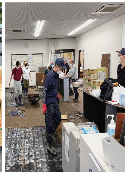
輪島支店での机・書類等の搬出作業
